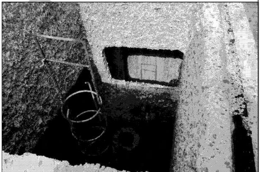
Accès au digesteur
