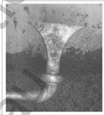
Dispositif d'injection d'eau blanche (Queue de carpe)
